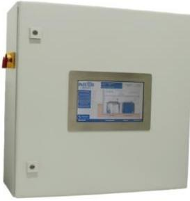
Die Steuerung einer Grauwasserrecyclinganlage mit I-CONNECT ermöglicht einen transparenten, überwachten Prozessablauf. Die Steuerung umfasst die Regelung der Gebläse für die Membranstationen und die Rohrbelüfter und deren Drucküberwachung sowie die Prozesssteuerung der Filtrations- und Rückspülpumpen, der Schlammumpen, des Vorfilterreinigungsventils und der Niveausonden zur Erfassung der Füllstände im Membranspeicher und im Klarwasserspeicher.
