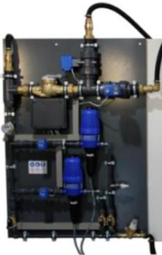
Die vollautomatische Reinigung wird über die zentrale Steuereinheit gesteuert. Über die Einstellung im Menü des Multicontrollers kann die gewünschte tägliche Reinigungsleistung eingestellt werden. Die automatische Reinigung wird zeitgesteuert aktiviert, z.B. alle 2 Wochen. Die Reinigung besteht aus zwei Reinigungsschritten, zunächst eine saure Reinigung durch Zitronensäure, zur Entfernung von Kalkbestandteilen. Der zweite Teil ist eine oxidative Reinigung mit Chlor, um Biofilm zu entfernen.
